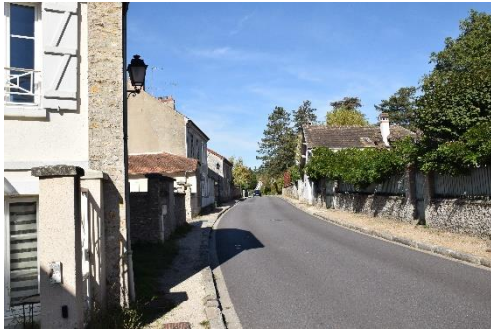
Vue du Bourg rue de Rambouillet
